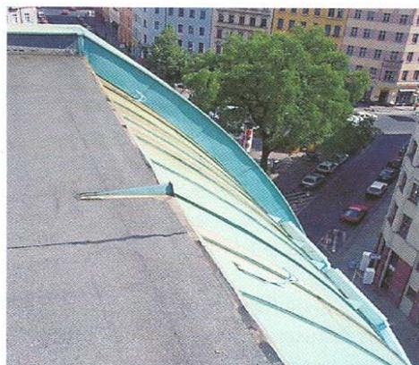
↑ Bei Edelmetall-Deckungen besteht ein hohes Risiko von Materialunverträglichkeiten durch Säureangriffe, von darüber liegenden Dichtstoffen.
