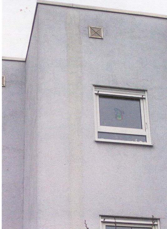
← Wasserlaufspuren an Fassaden bilden in der Regel einen nicht hinnehmbaren optischen Störfaktor.
